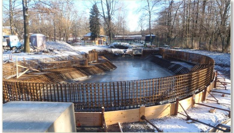
Stahlbetonbecken: Schalungs- und Bewehrungsarbeiten
