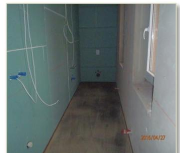
Alle Arbeiten wurden gemäß dem Bauablaufplan in den Winterferien realisiert. Bereits drei Wochen später konnten die ersten WC-Elemente gestellt werden. Nachdem die Bauarbeiten sowie die Installation für Heizung/Lüftung/Sanitär/Elektro und der Trockenbau abgeschlossen waren, konnte im April der Rohfußboden eingebracht werden.
