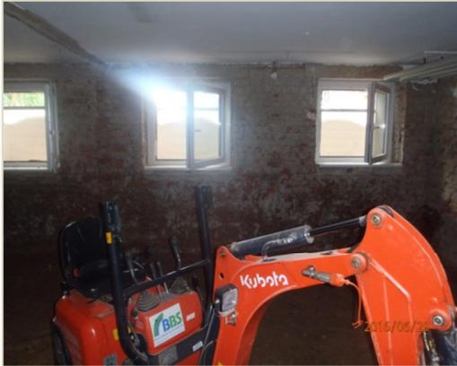
Baggerarbeiten im Fußbodenbereich der Ausgabeküche für neue Entwässerungsleitungen
