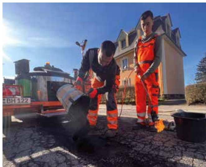
Die Asphalt-Cowboys von L.-O.: Bauhof-Mitarbeiter Nico Brendel und Praktikant Johannes Sonntag beim Verschließen der Schlaglöcher auf der Hainstraße.
