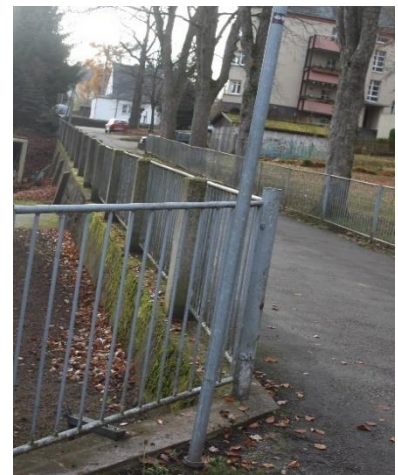
Stützmauer Oberer Gutsweg
