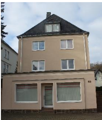
Frohnbachstraße 53 nach realisierter Sanierung von Dach und Fassade
