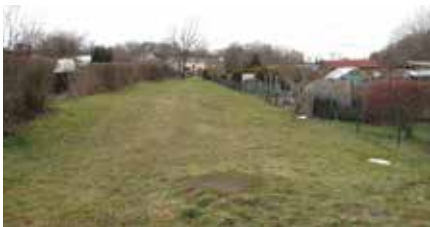
Jetzt läuft der Limbach verrohrt durch die Kleingartenanlage „Bodenreform“, hier mit einem Einstiegsschacht (Foto: Reiner Wagler)
