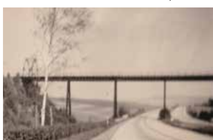
Auritztalbrücke über BAB 4
