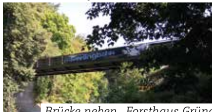
Brücke neben „Forsthaus Grüna
