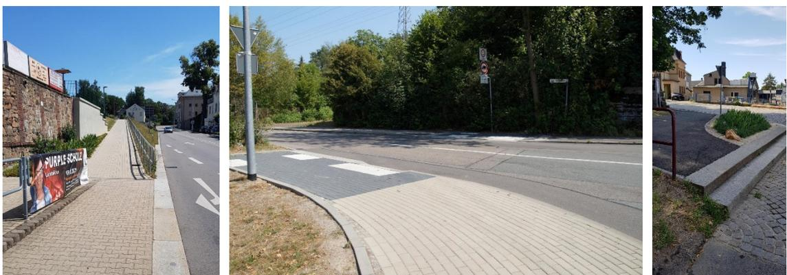
Fotos: Barrierefreie Straßenraumgestaltung - Gehwegrampe (links), taktile und stufenfreie Querungsstelle auf Betonpflaster (Mitte) und Negativbeispiel eines als Treppe endenden Gehwegs (rechts)
