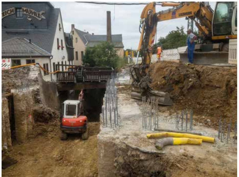
So sah es auf der Baustelle noch 2019 aus...
