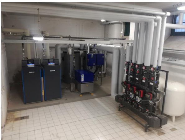
Quelle: Stadtverwaltung/ Blockheizkraftwerk
