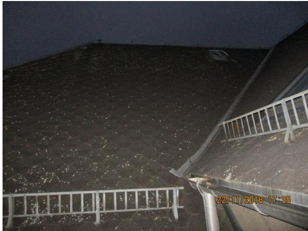
Quelle: Stadtverwaltung Südseite unsaniert
